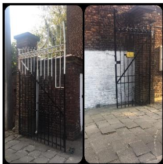
Rénovation de la grille principale, août 2019
